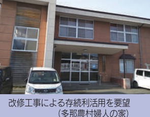
改修工事による存続利活用を要望 (多那農村婦人の家)
